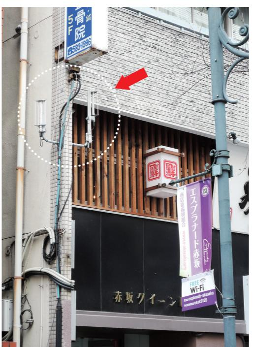
電波の効率化のため、アンテナは2階近くに設置。
